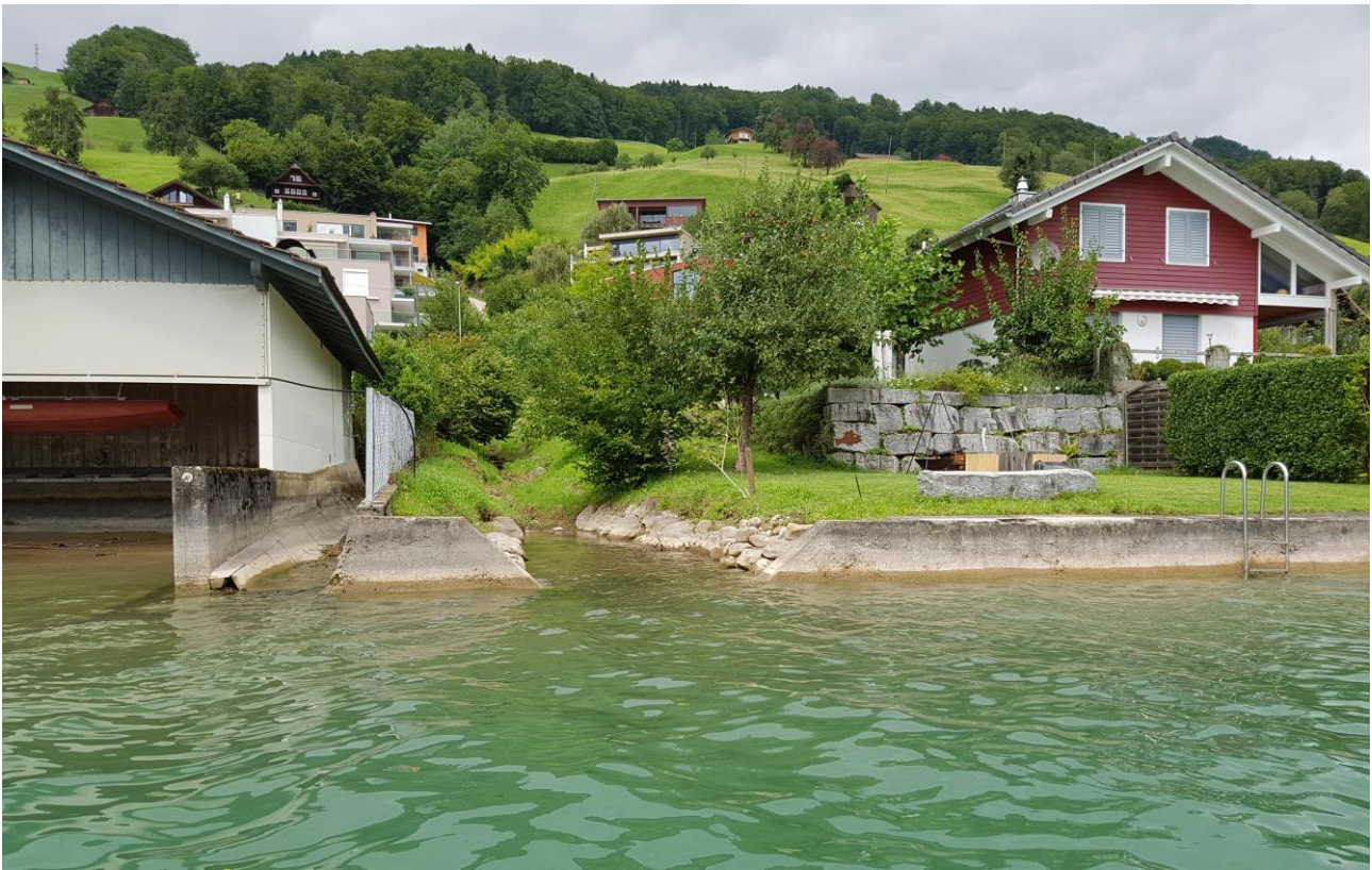
Abbildung 4-7. Beispiel für einen hart verbauten Zufluss im Sarnensee.
