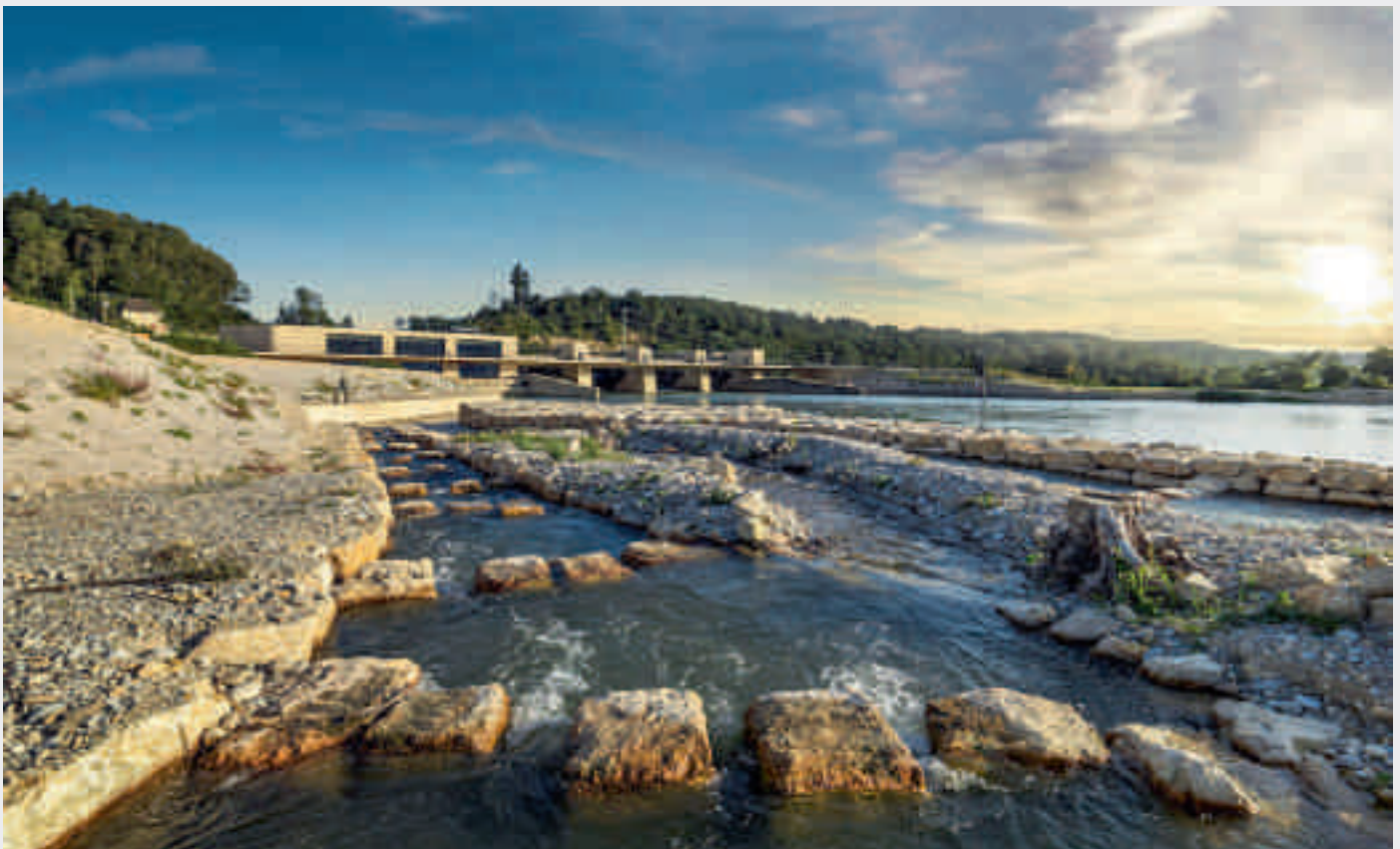
Fig. 4 Das neue Flusskraftwerk Hagneck (BE) ging 2015 in Betrieb. Im Vergleich mit der alten Anlage wurde die Stromproduktion um 40% gesteigert, das Projekt gewährleistet aber auch den Hochwasserschutz und wertet Flussökosystem und Landschaft auf – unter anderem mit einer Fischtreppe.
