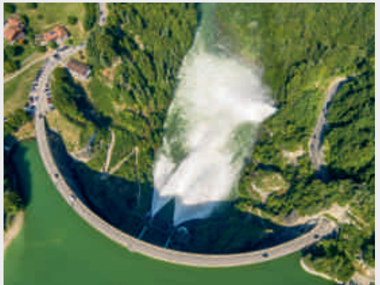
Fig. 5 Im September 2016 wurde beim Kraftwerk von Rossens (FR) ein künstliches Hochwasser erzeugt. Ziel war es, den verarmten Geschiebehalt der Saane zu reaktivieren.
